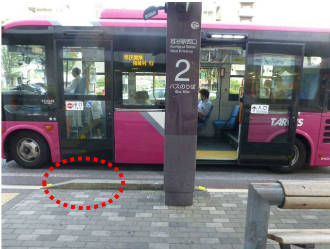
写真2：工事前のバス停の状況
