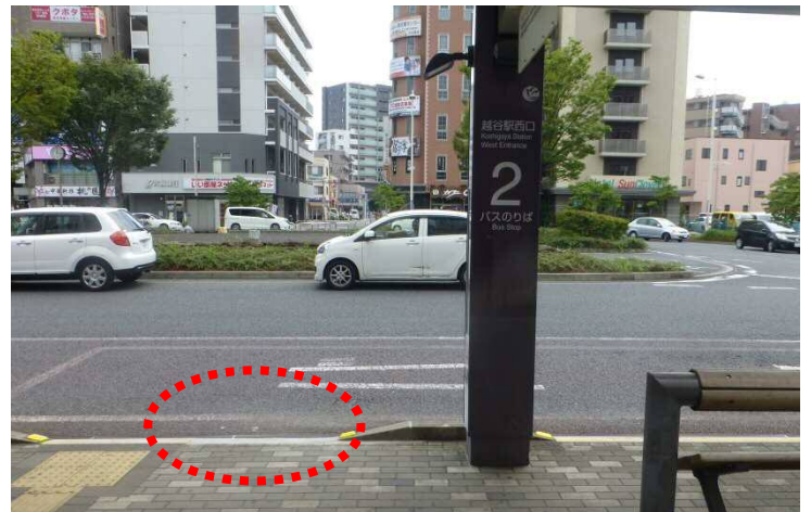
写真3：工事後のバス停の状況
