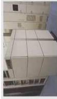
通信系の制御を行う指令システムの中枢装置です。安全性を考慮し、現用・予備の二重化構造を採用しています。
