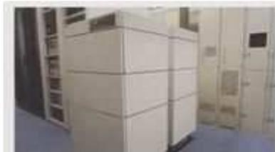
通信系の制御を行う指令システムの中核装置です。安全性を考慮し、現用・予備の二重化構造を採用しています。
