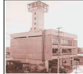
消防本庁舎を建替え 《昭和42年8月》
