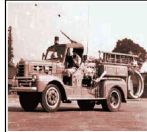
開設時の水槽付消防ポン プ自動車
