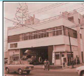
消防署蒲生分署を開署 《昭和48年3月》
