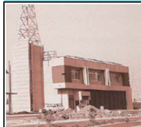
消防署谷中分署を開署 《昭和46年2月》
