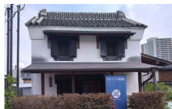
改修後の状況
