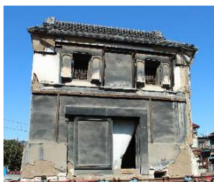
改修前の状況
