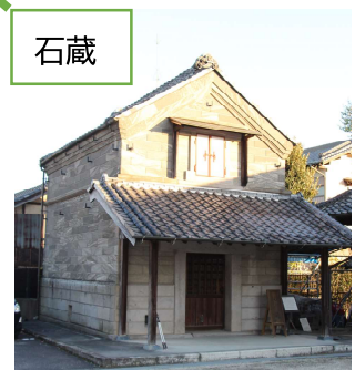
房州石を組み上げた昭和前期の建築。米蔵として使用。内部の壁には等間隔に板を立て、米俵が石壁に直接接しないような工夫が施されている。
