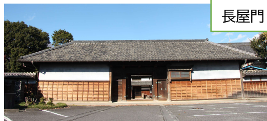
明治19年(1886年)建造。中央に大扉と潜り戸がある。扉の東側には守衛部屋と農具部屋、西側には「前蔵」がある。外壁は松煙墨と漆喰を混ぜた鼠漆喰。
