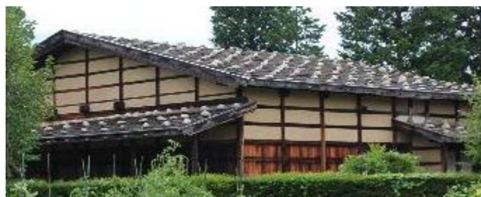
↑ 石置き板葺きの曾根原家住宅(安曇野市)
