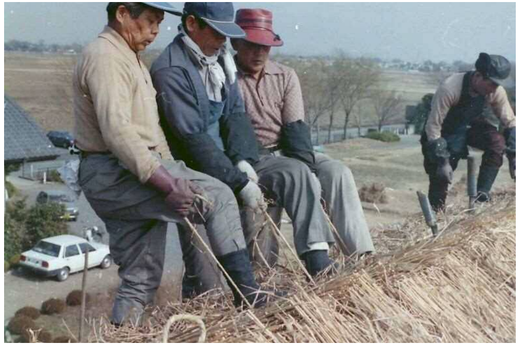
屋根の峰（棟）でグシの基礎を作っています。
