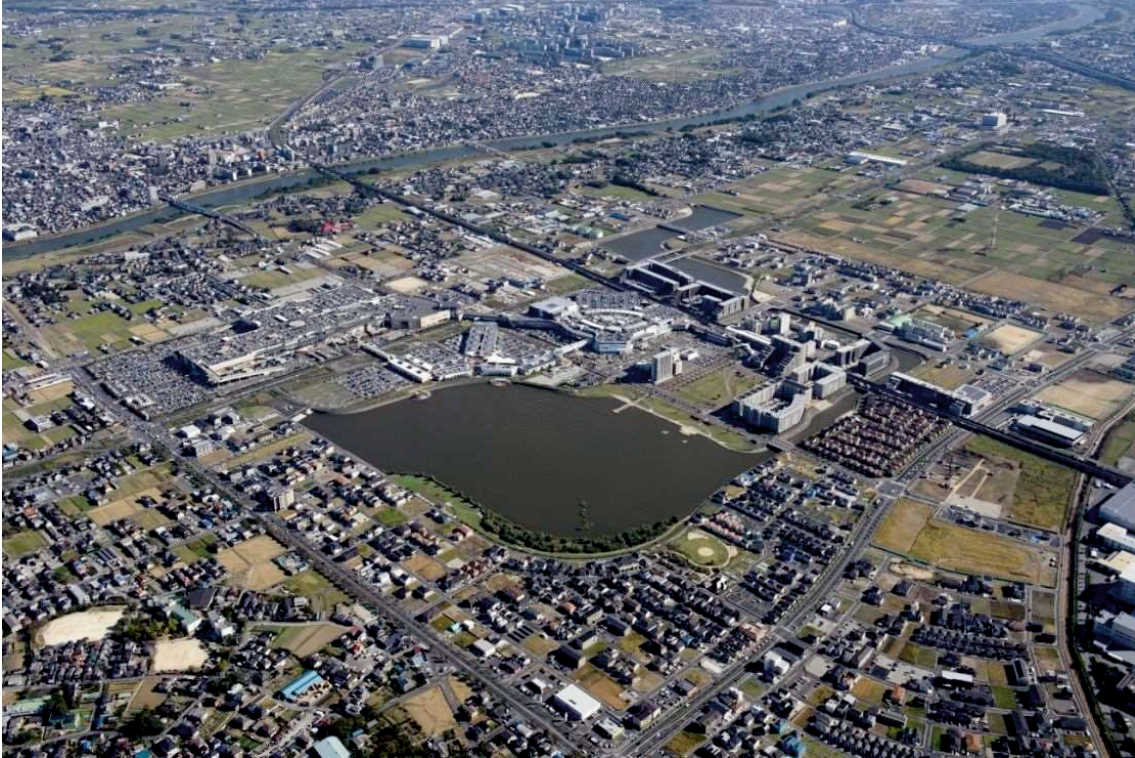
①空撮写真（調節池の北西方面から）
