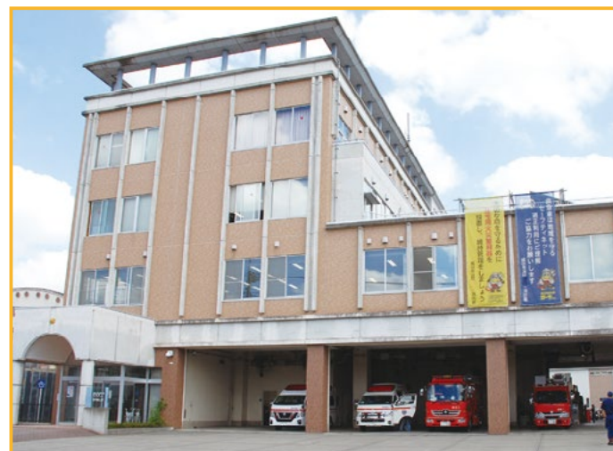
消防しょ本しょ（消防局がある）
