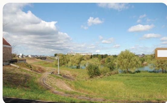
大吉調節池（通常時）
