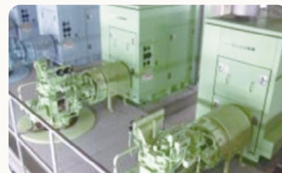
市内の雨水ポンプ場
