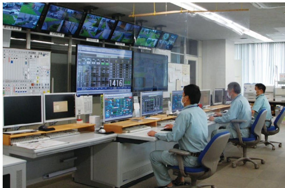
水道企業団の中央管理室
