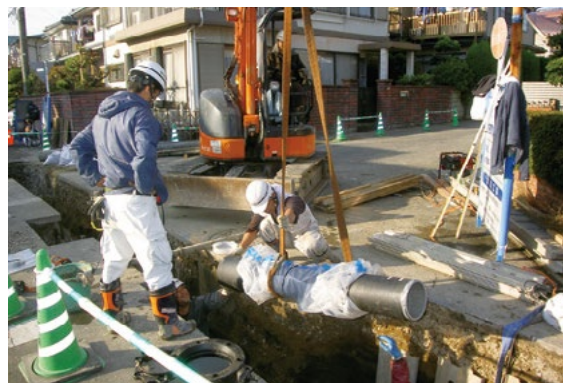
水道管の取りかえ
