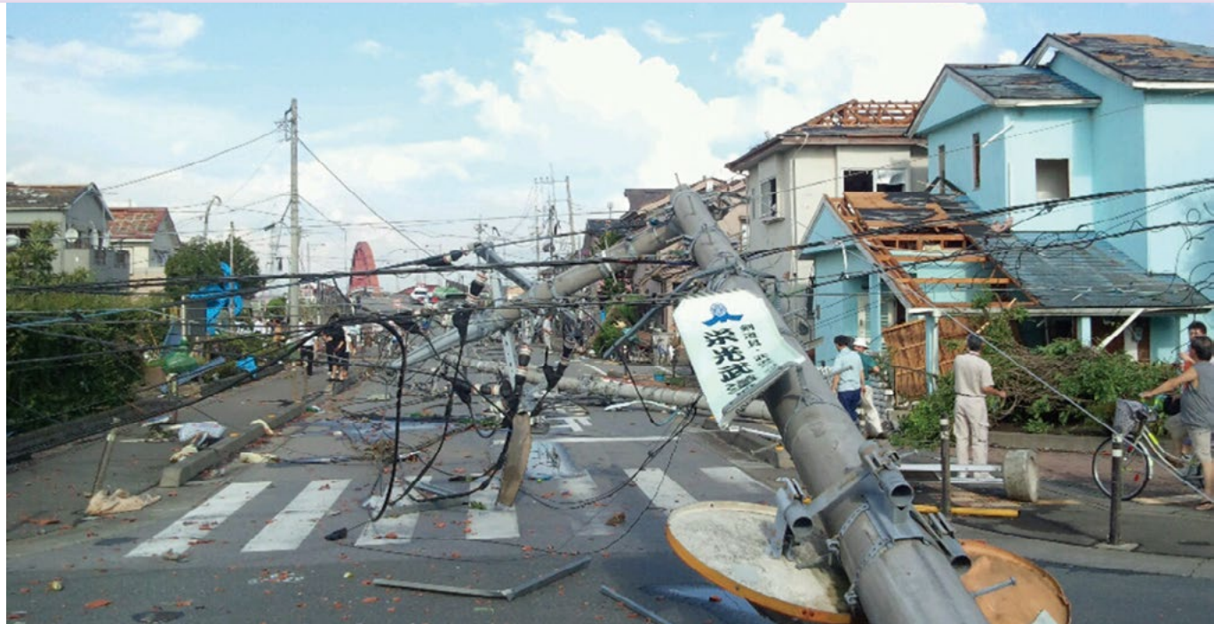
越谷市で発生したとみられる竜巻によるひがいの様子（2013年9月）
