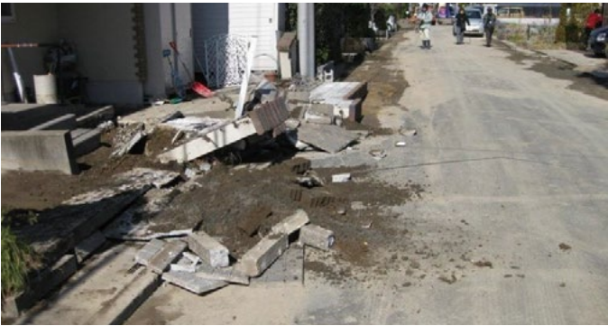
地震でこわれたブロックべい（提供：久喜市）
