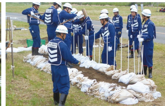
積み土のう工
