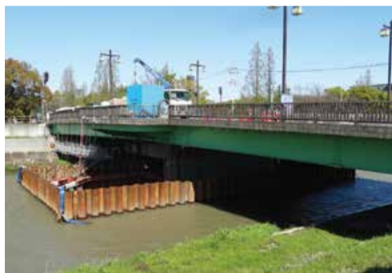
耐震補強工事中の千代田橋
