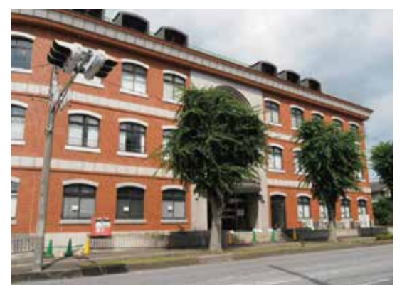
改修工事が進む大沢地区センター・公民館
