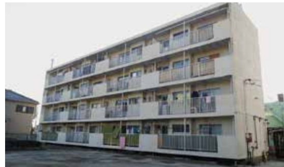
市営住宅(川柳町中層住宅)
