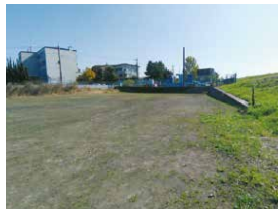
新方川周辺にある既存の調整池
