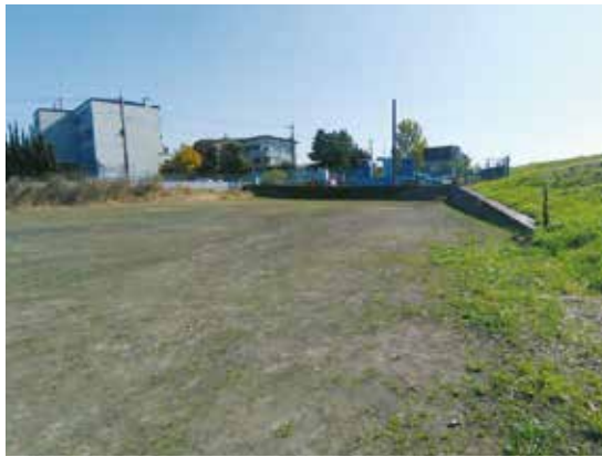
新方川周辺にある既存の調整池
