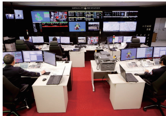
現在の越谷市消防指令センター
