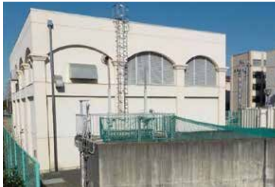
東越谷雨水ポンプ場
