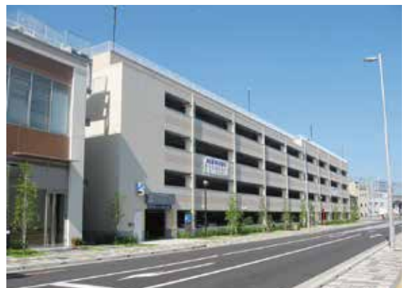
越谷駅東口駐車場
