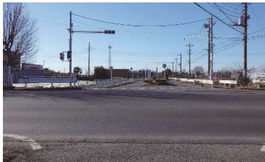
6625橋(小曾川地内)
