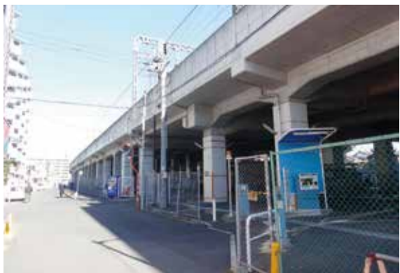
高架化されている北越谷駅周辺
