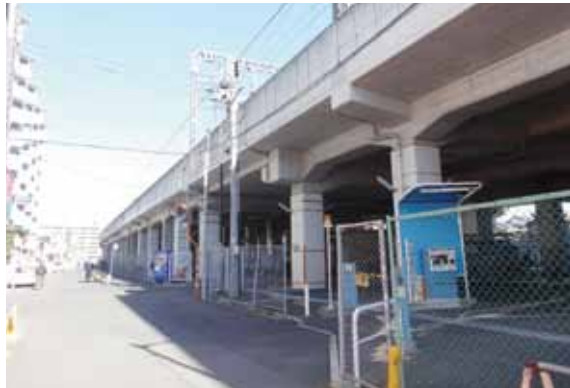
高架化されている北越谷駅周辺
