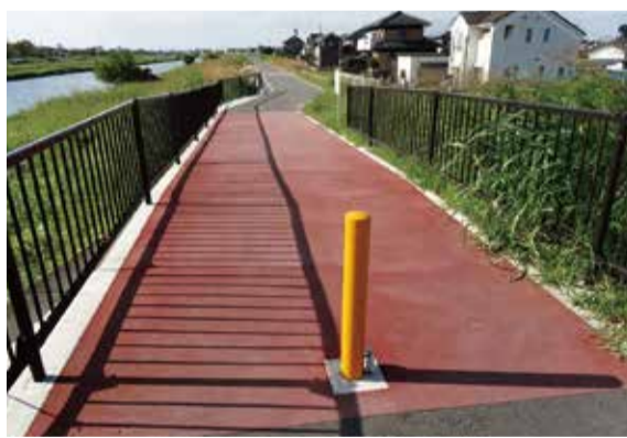
整備された元荒川沿いの遊歩道
