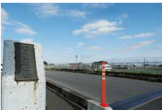
耐震整備工事予定の間久里新田橋
