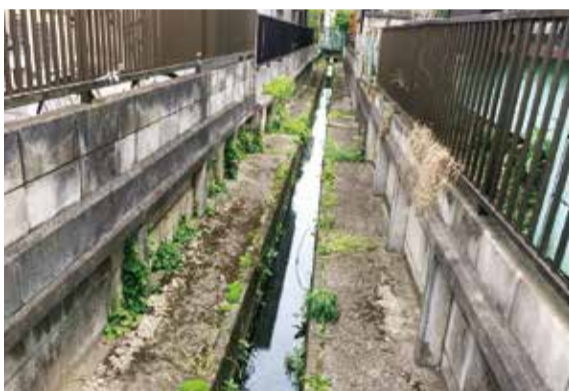
蓋かけされていない水路
