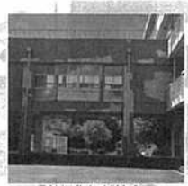
『老朽化した校舎』
