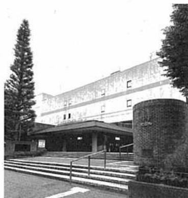
越谷サンシティ ホール棟
