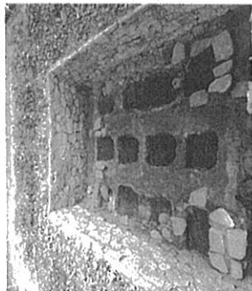
土間部コンクリート基礎の撤去後
