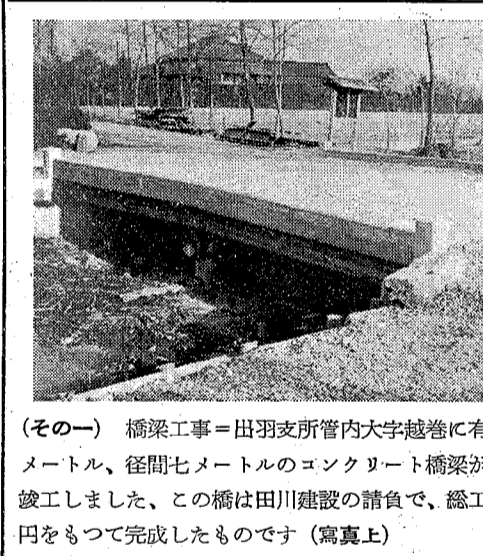
(その一) 橋梁工事=出羽支所管内大津越巻に有効巾五・五メートル、径間七メートルのコンクリート橋梁が去月二十日竣工しました。この橋は田川建設の請負で、総工費三三五五万円をもつて完成したものです(寫真上)
