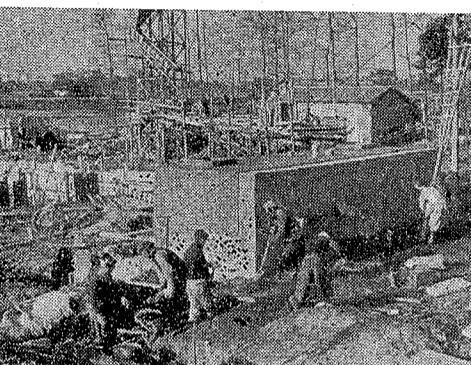
進捗する上水道工事…久伊豆の森に機械化による上水道建設工事の勇壮な音は、連日コダマし、260メートルの井戸よりもすみ、吸水工事、浄水場の杭打工事、ポンプ場工事、配管工事など広範囲の突貫工事がづけられています
