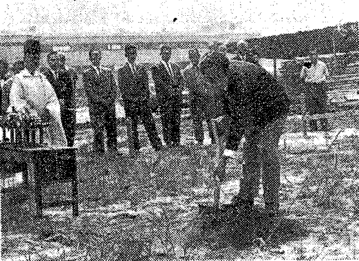
＜蒲生小学校増築工事はじまる＞
