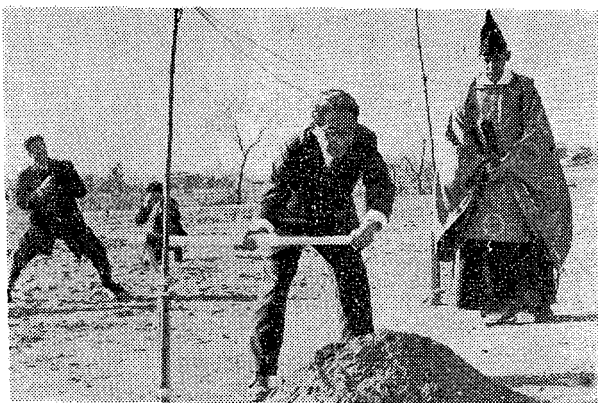
＜南部浄水場建設始まる＞
