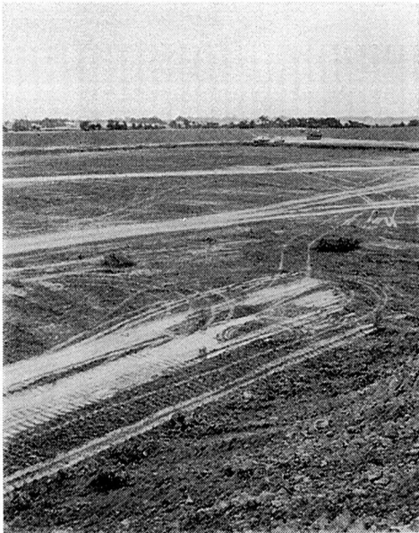
整地が進む武蔵野線貨物駅
