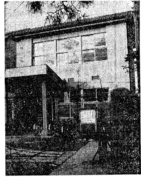
写真は旧町立図書館(現越ヶ谷小学校科学館)
