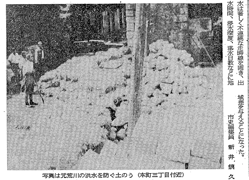
写真は元荒川の洪水を防ぐ土のう(本町三丁目付近)
