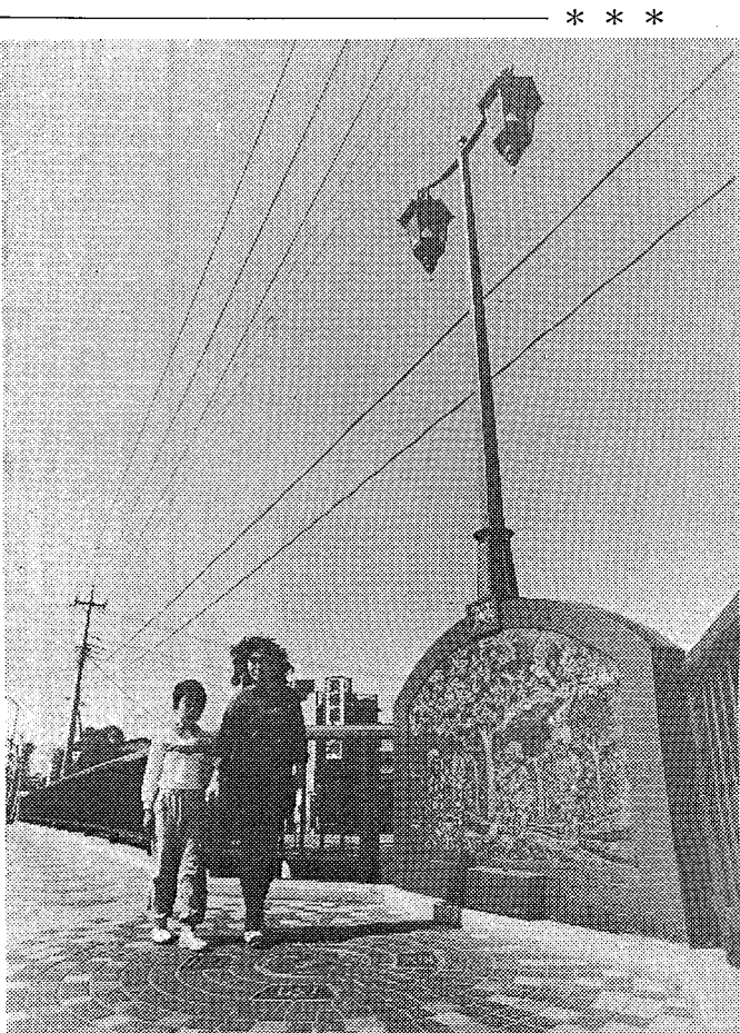
街のデザイン 県道足立越谷線が元荒川を越えるところに架けられている「元荒川橋」。老朽化した欄干の改修工事が進められていましたが、このほど完成しました。
