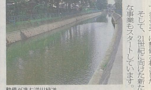
整備が進む逆川緑道
