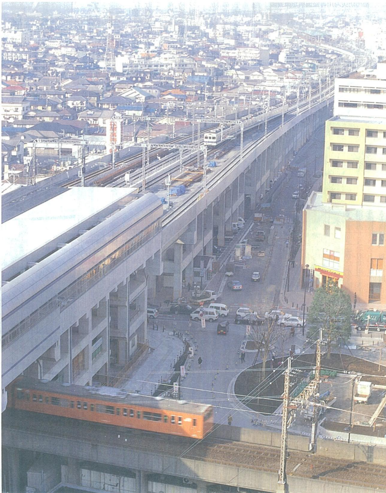
高架複々線化工事が進む新越谷駅周辺。3月25日からは新越谷駅にすべての準急電車が停車します
