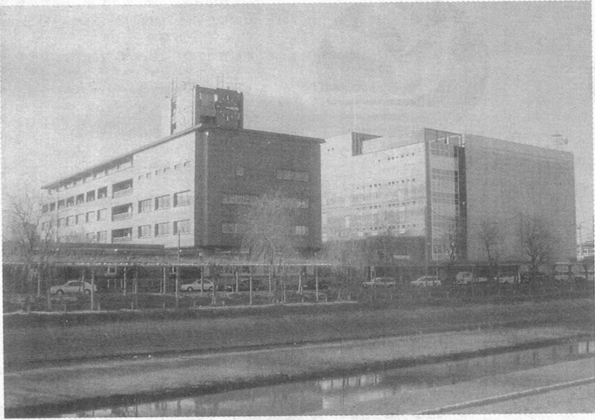
4月の業務開始に向け、市役所庁舎の増築工事が進んでいます(写真右側)
