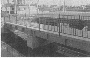
完成した伊原橋歩道橋
