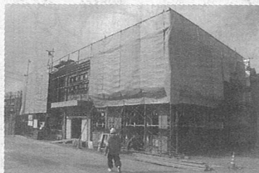
現在は外壁工事が行われています
