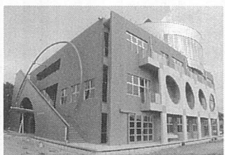
建設が進む(仮称)越谷市先端科学技術体験センター
