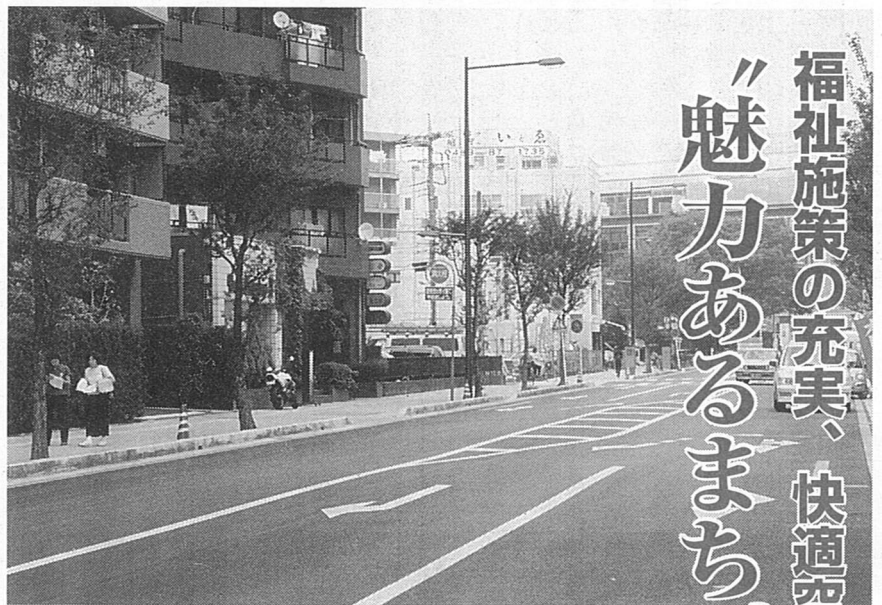
▲電線類が地中化された新越谷駅西口
