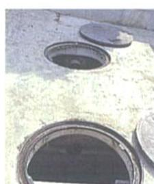
不用となった浄化槽を利用した雨水貯留施設
