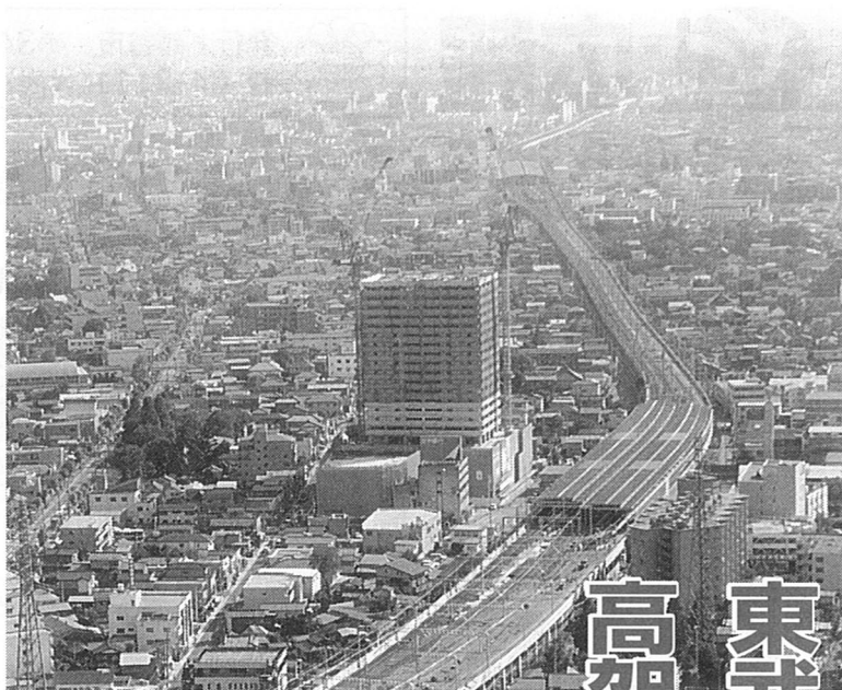
▲高架複々線化の完成に向けて整備が進められている北越谷駅周辺
