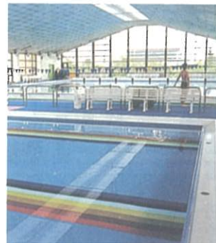
市民温水プール
