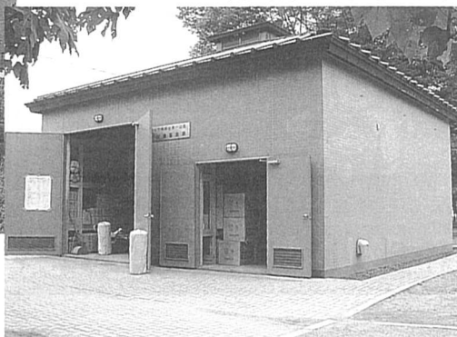
南越谷第1公園の備蓄倉庫
