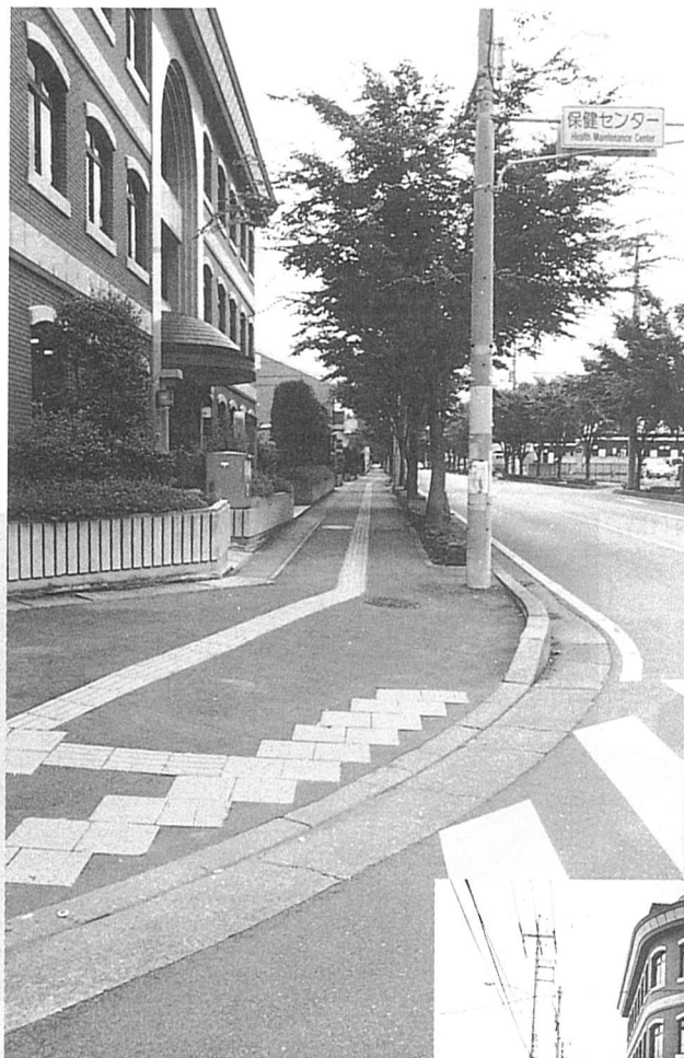
公共施設と主要駅を結ぶ誘導ブロック (保健センター付近)
