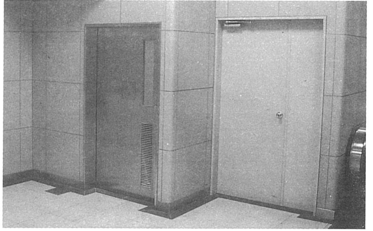
北越谷の障害者用トイレ
