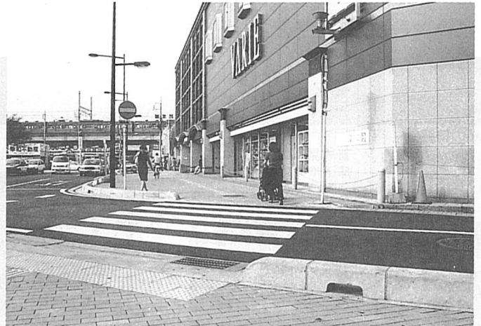
駅周辺の段差の解消や誘導ブロックの設置（新越谷駅西口）
