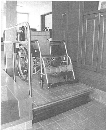
リフトの昇降で段差が解消され、 車いすのまま各部屋に移動ができます
