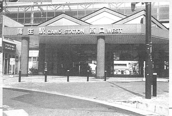
駅の入口と歩道の段差解消をしています
