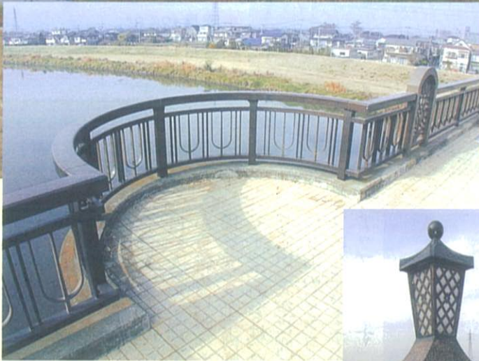
●橋長100メートル ●幅員16メートル
