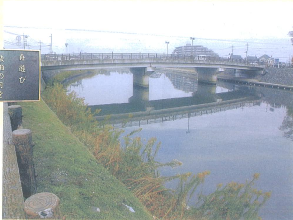
● 橋長69.4メートル ● 幅員12メートル
