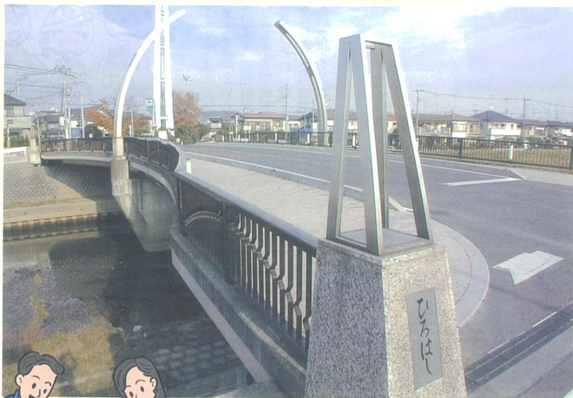
● 橋長45.3メートル ● 幅員12～19メートル
