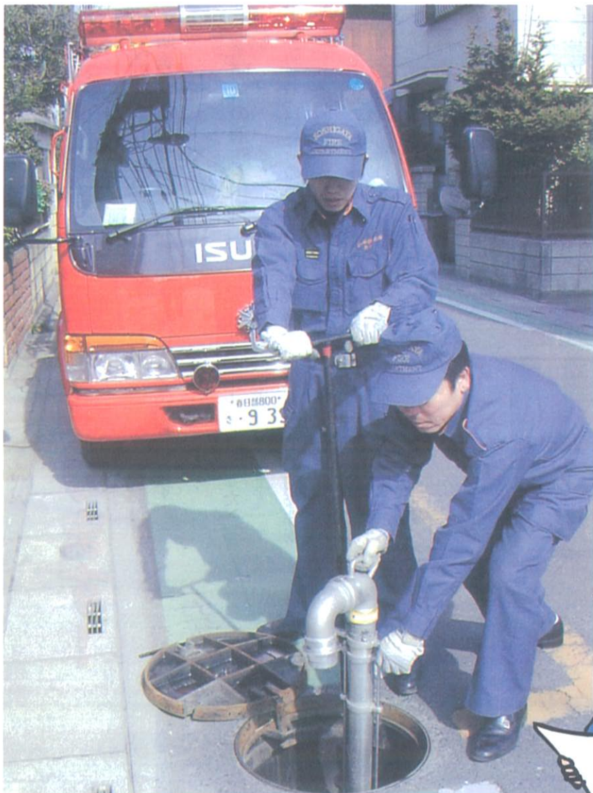
市内4,592カ所の消火栓を いつでも使用できるように点検しています
