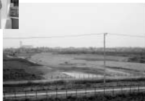
調節池掘削工事 (平成14年度末現在、約47%完成)
